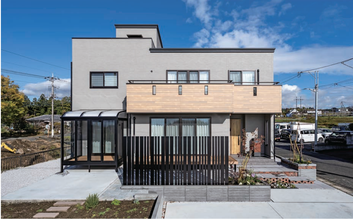
外観で意識したのは、屋上があからさまに周囲から見えないようにすること。3階となる踊り場部分が僅かに覗くものの全体的にスクエア(四角)に設計することで、その存在を上手に消している。また、ボリュームがあるぶん見た目が重くなりすぎること防ぐため、明るくナチュラルなカラーでコーディネート。
