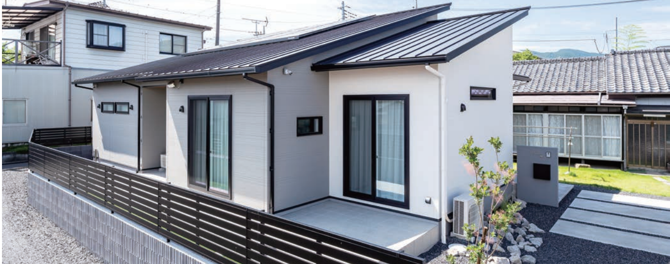
塗り壁をイメージしたサイディングによる、ホワイト×グレーのツートンカラー。コの字型の中庭は外干しスペースとして重宝されるほか、ランドリールームから出入りできる。また、小屋裏を実現するための片流れ屋根は陽当たりが良いため、7kWの太陽光パネルを搭載。「緑に触れる暮らしを楽しみたい」との意図から植栽したスモークツリーやユキヤナギも見所。(この見開き頁の写真はM氏邸)
